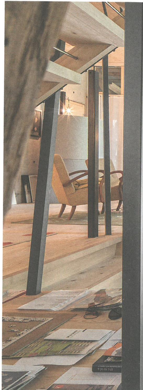
Rechts: Das offene Raumgefüge: frei in der Höhe versetzte Plattformen aus Vollholzdielen in Stahlrahmen, getragen von schmalen, gegeneinander geneigten Vierkantrohren; kurze Holztreppe; Raumteilung durch Glasscheiben und Vorhänge; Belichtung über Giebel- und Dachverglasung
